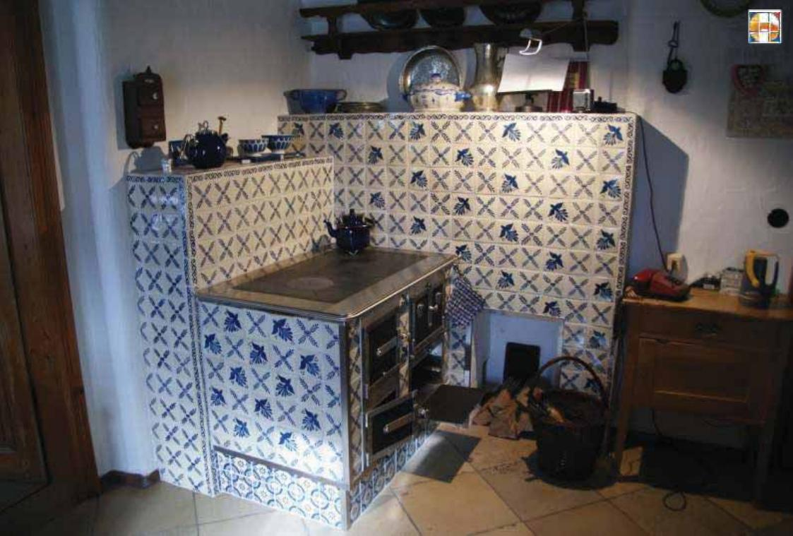
Energie doppelt nutzen - Kochen und Heizen in einem. Der Kachelherd als ideale Zusatzheizung bei gleichzeitiger Nutzung als vollwertige Kochstelle. Wärmeabgabe über keramische Züge als Strahlungswärme- Wärmeabgabe über Backrohr und Herdplatte oder Wärmeabgabe über Warmluft bzw. Warmwasser.
